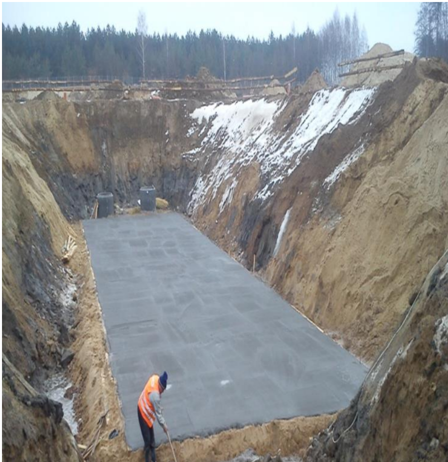
Budowa zbiornika ścieków
