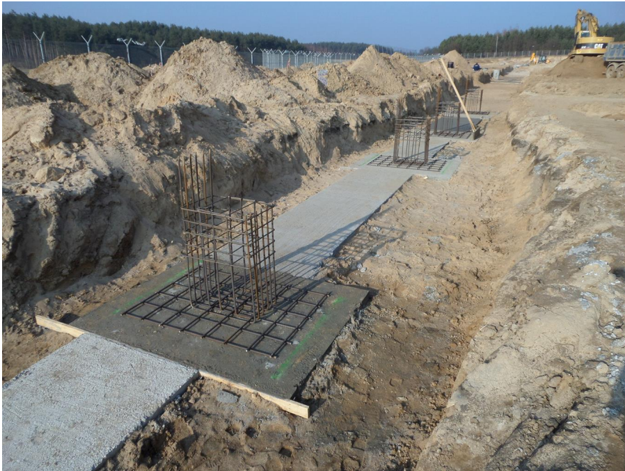
Ławy fundamentowe hali sortowni
