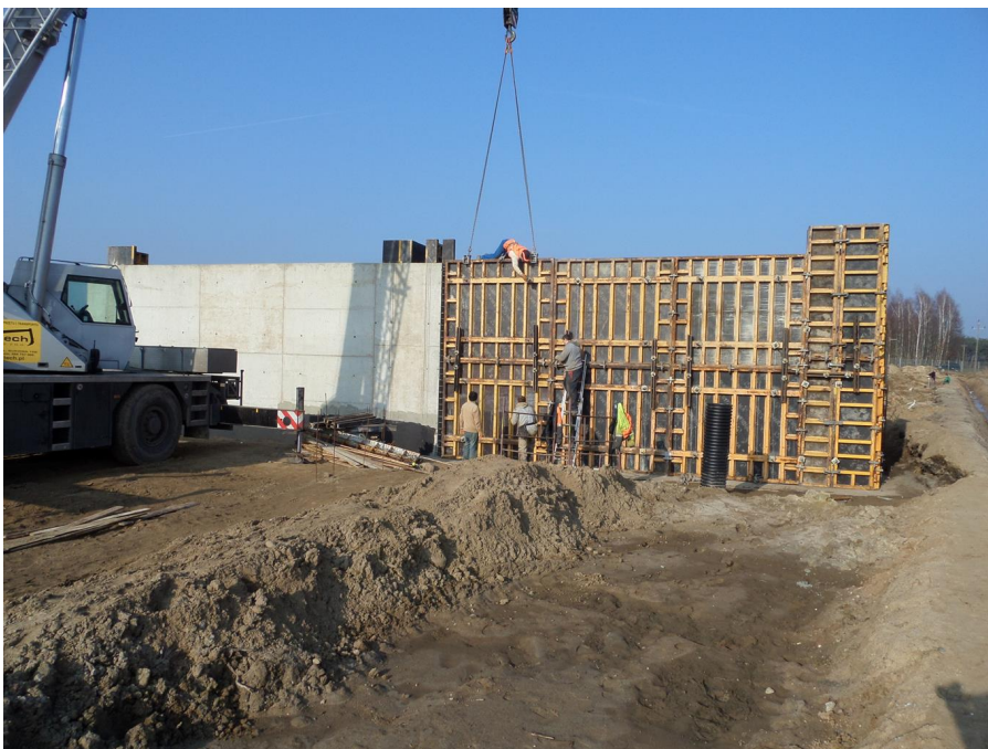
Budowa boksu na odpady zielone
