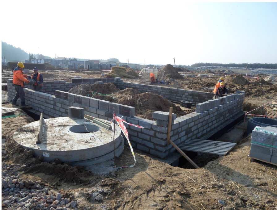
Budowa punktu demontażu
