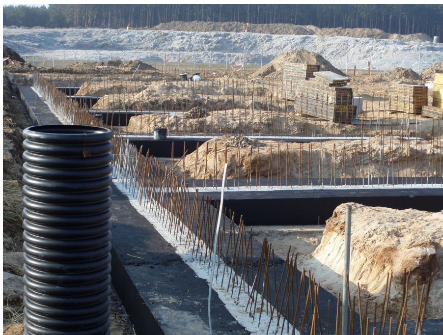
Fundamenty boksów na odpady
