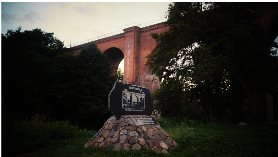
Wiadukt w Kozłowie
