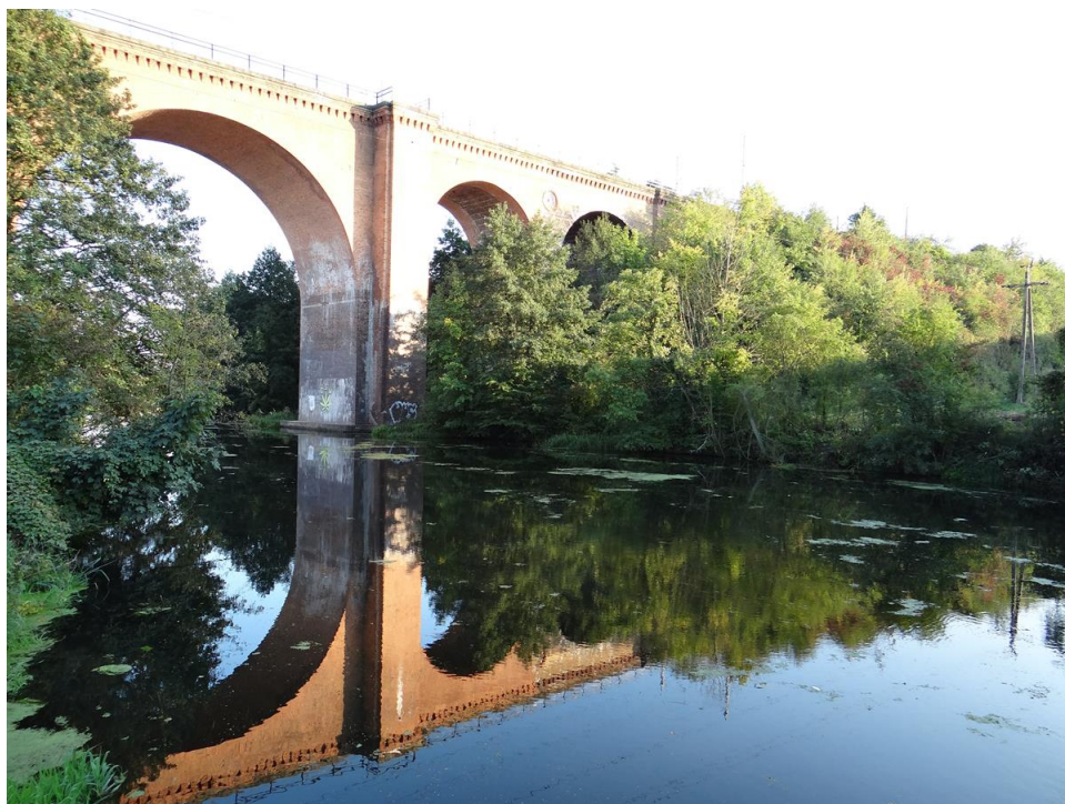
Wiadukt w Kozłowie
