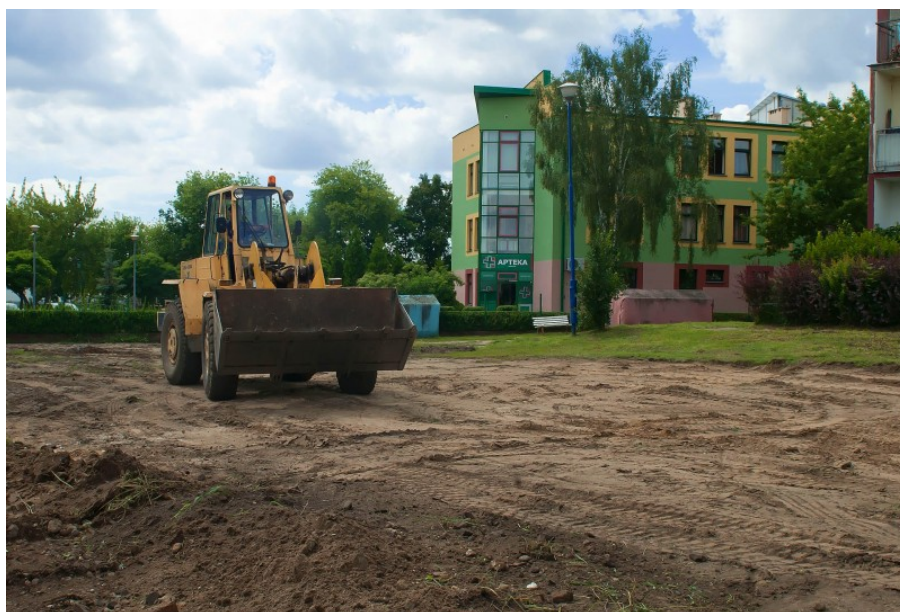
Budowa parkingu przy Miejsko-Gminnej Przychodni
