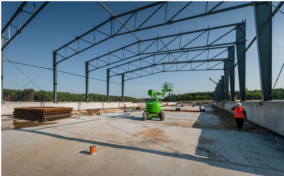
Montaż hali stabilizacji
