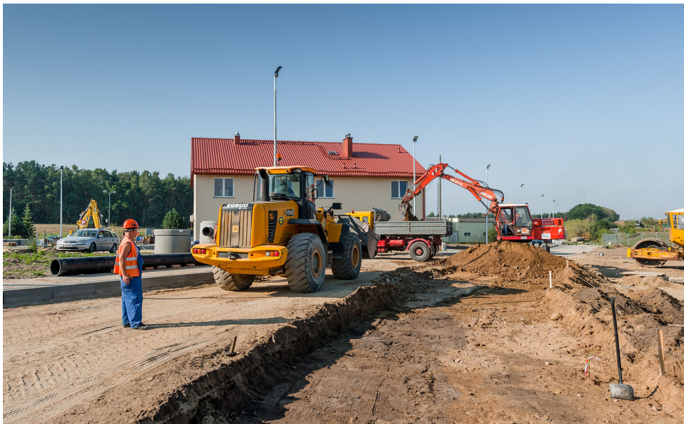
Budowa placów manewrowych
